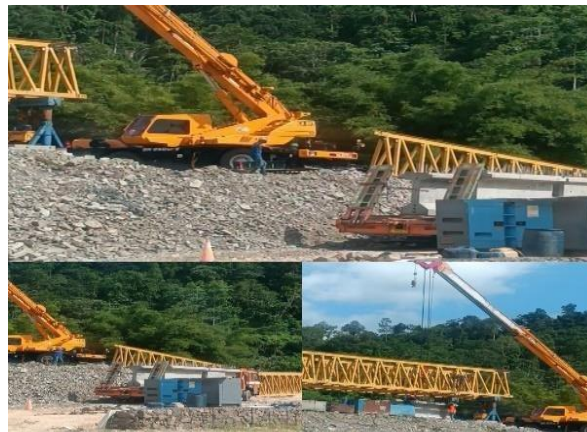
Gambar 2. Proses supply girder dilakukan secara segmental
