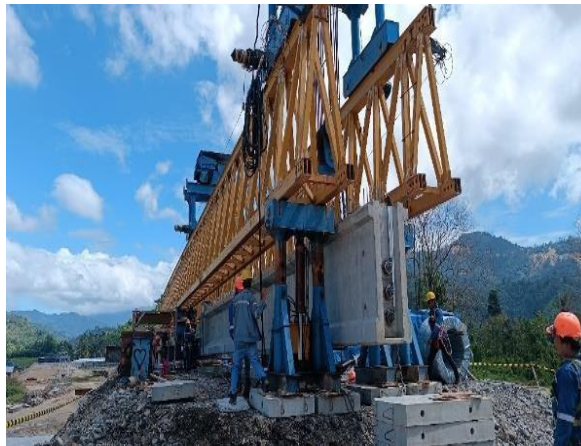
Gambar 6. Proses pengaitan girder dengan sliing besi pada launcher
